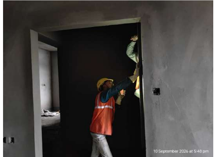
6F - Internal Plastering
