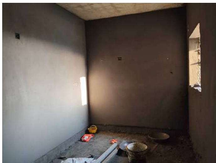
6F - Internal Plastering
