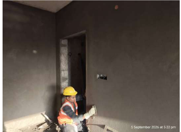
6F - Internal Plastering
