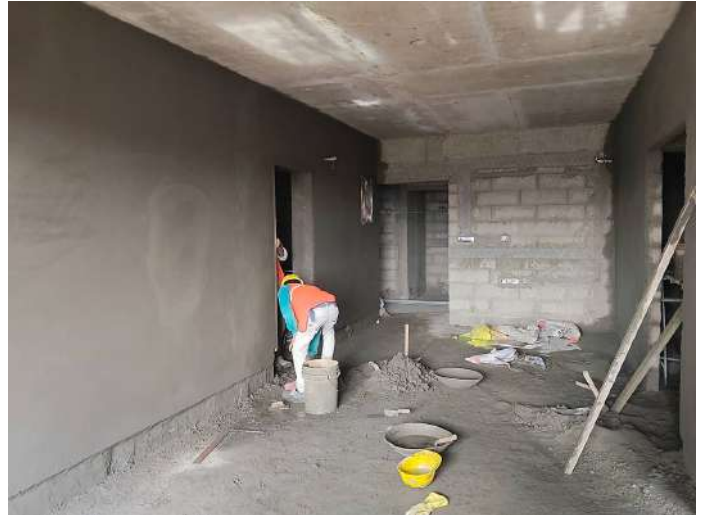
6F - Internal Plastering
