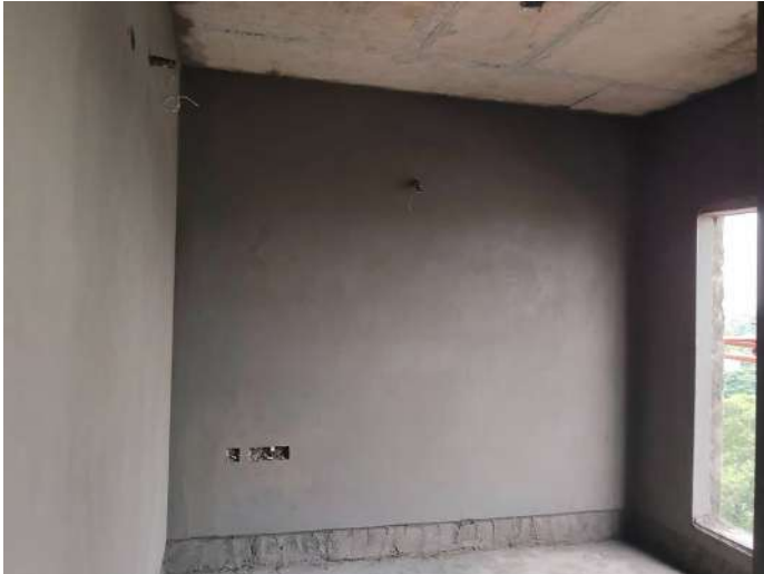
6F - Internal Plastering
