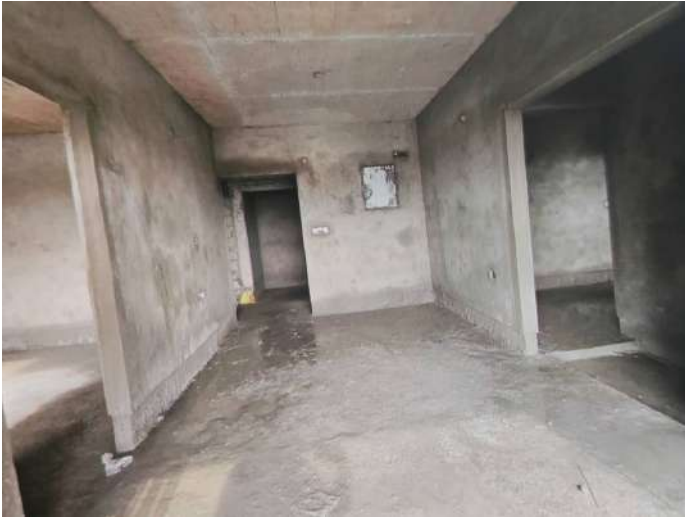
6F - Internal Plastering
