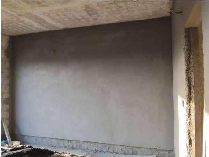
6F - Internal Plastering
