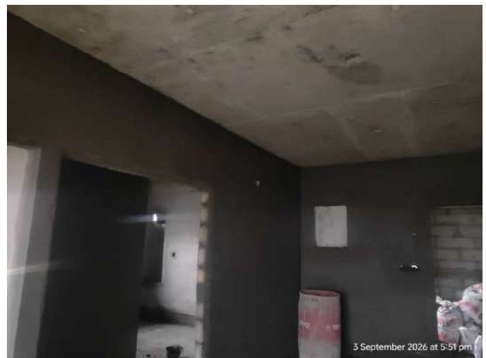
6F - Internal Plastering
