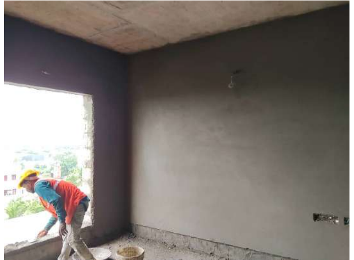
6F - Internal Plastering
