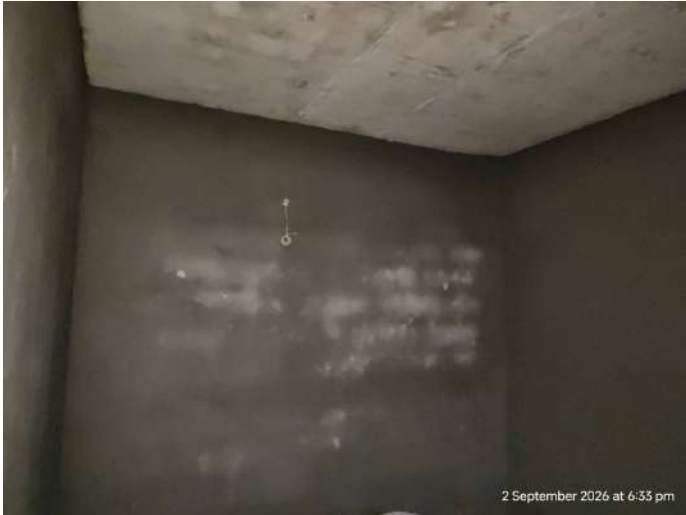
6F - Internal Plastering
