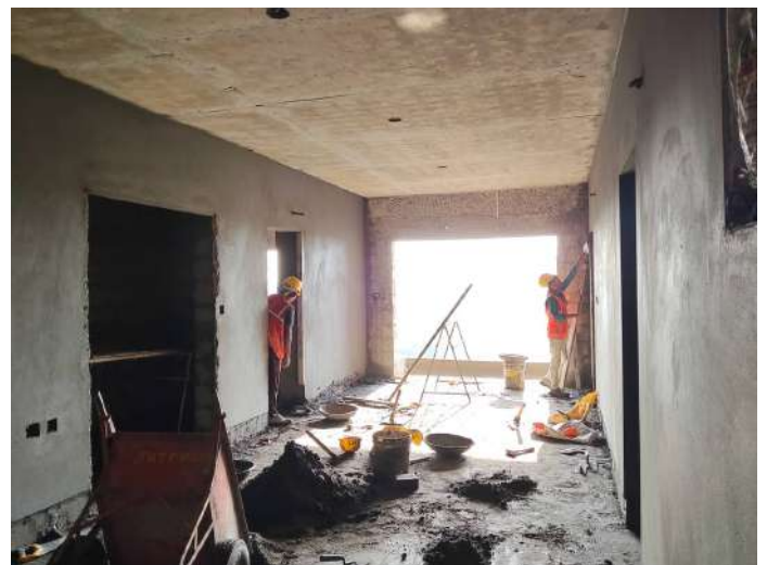
6F - Internal Plastering
