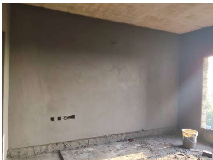
6F - Internal Plastering
