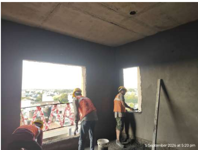
6F - Internal Plastering
