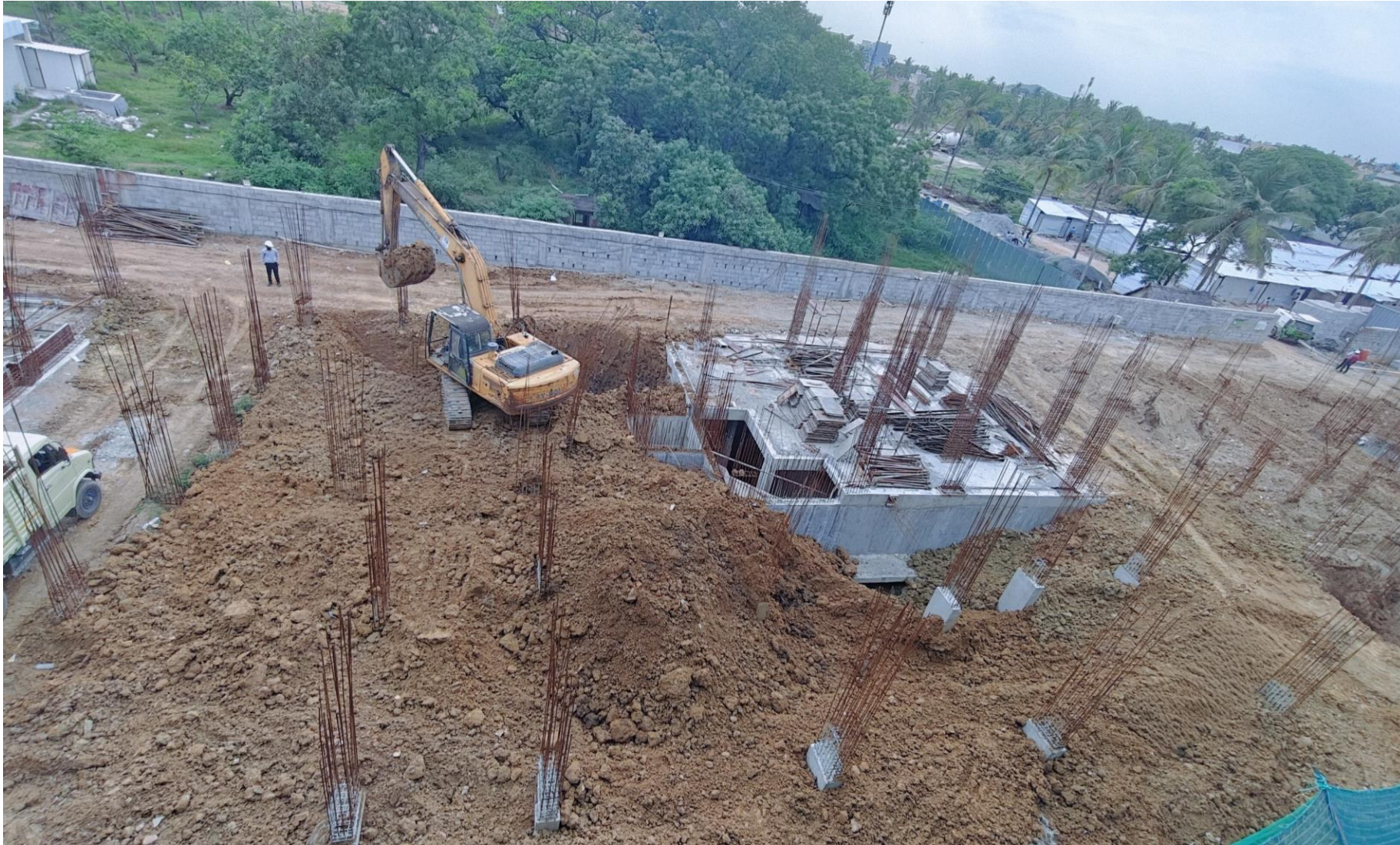
Block-1- Pour 3-Soil Filling work in progress
