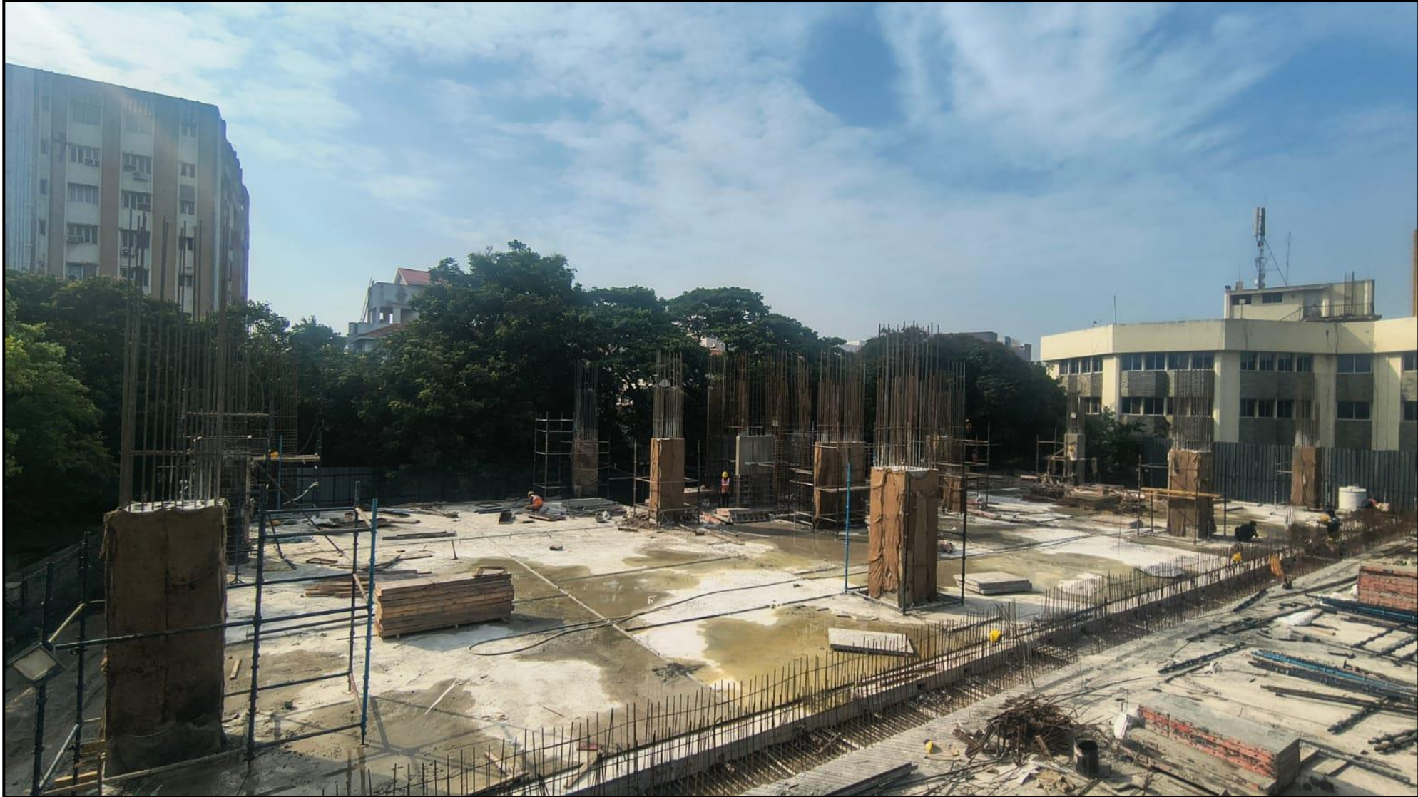
First Floor – Pour 2 – Columns Curing work
