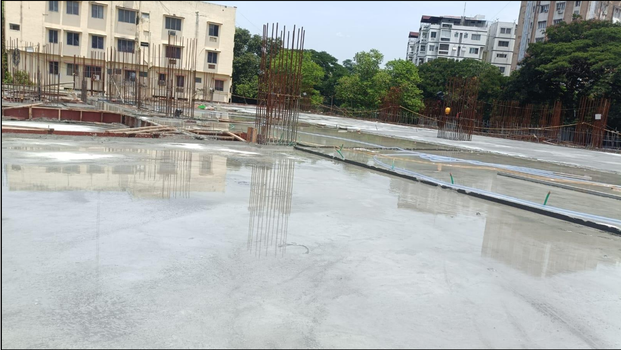
Stilt floor roof slab Pour 1 - Curing work
