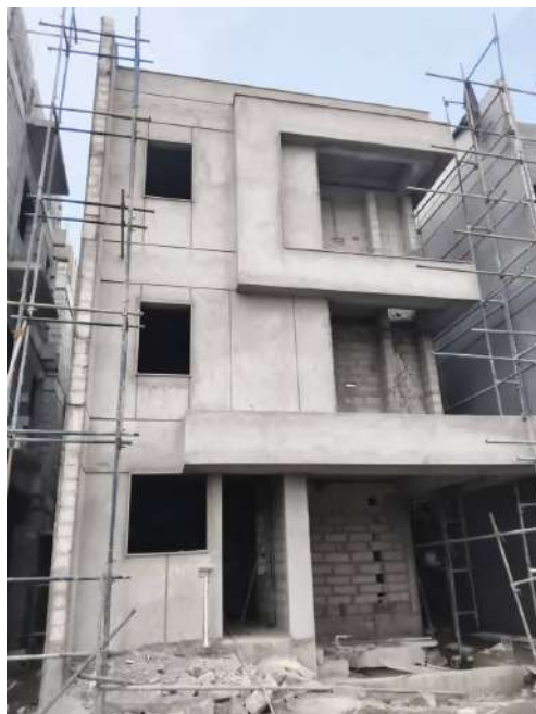
V44 - External Plastering
