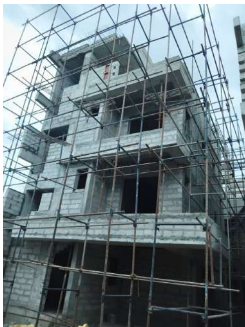
V39 - External Plastering
