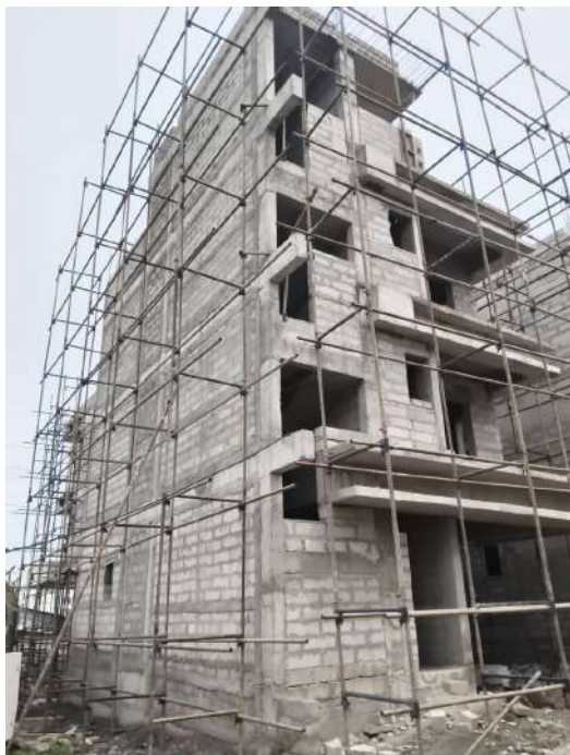
V39 - External Plastering
