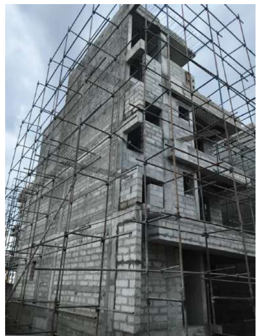
V39 - External Plastering
