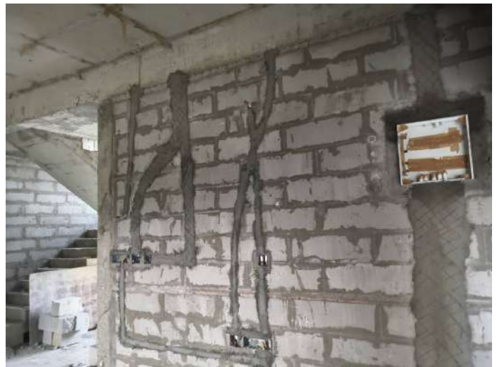
V23 - Instllation of Wall chasing & Electrical conduits
