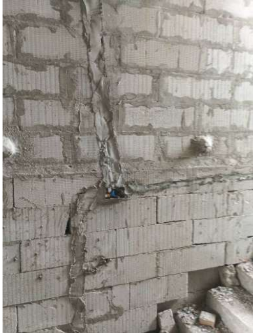
V29 - Instllation of Wall chasing & Electrical conduits
