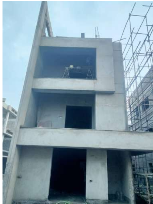
V41 - External Plastering
