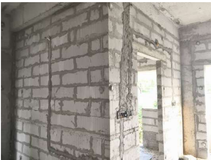
V24 - Instllation of Wall chasing & Electrical conduits
