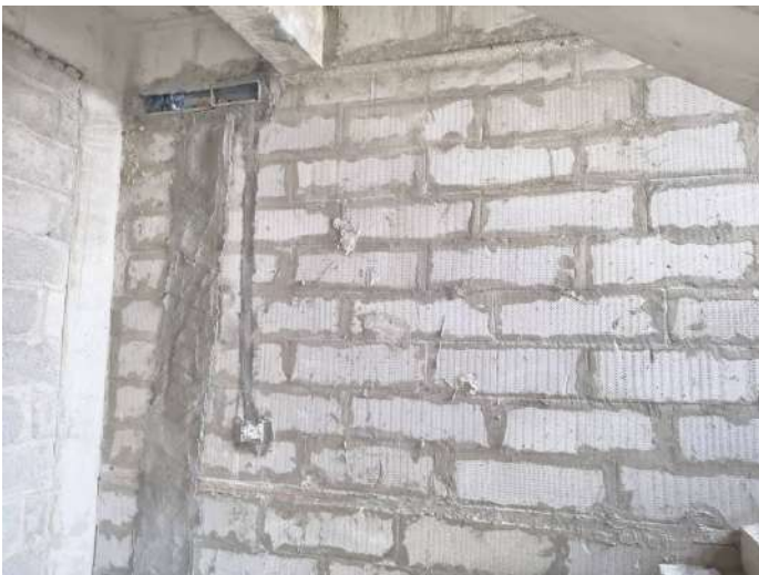
V23 - Instllation of Wall chasing & Electrical conduits
