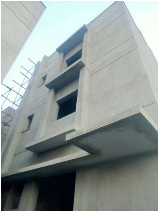
V39 - External Plastering
