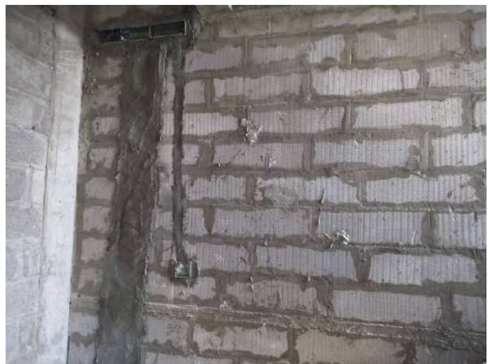
V24 - Instllation of Wall chasing & Electrical conduits
