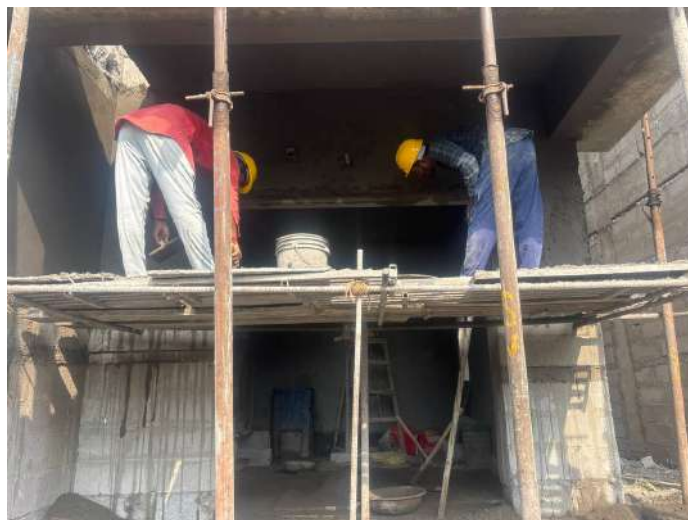
V107 - External Plastering
