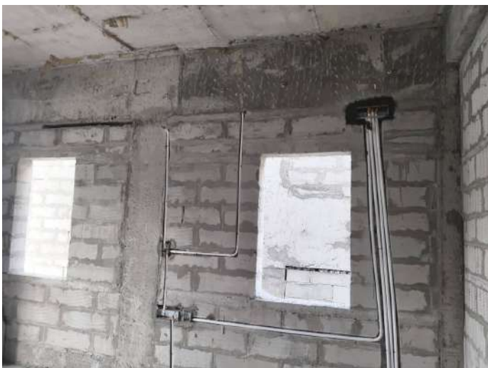
V23 - Instllation of Wall chasing & Electrical conduits
