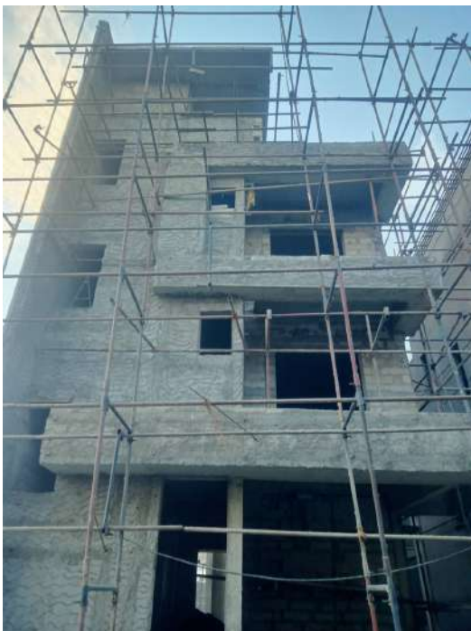
V39 - External Plastering
