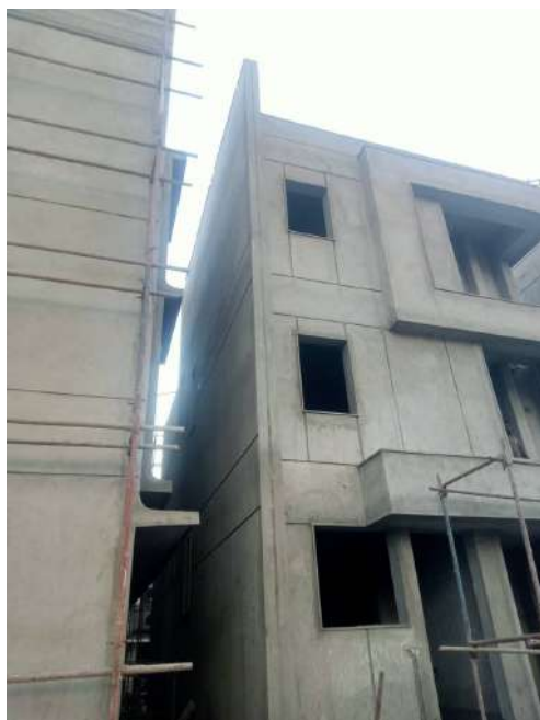
V44 - External Plastering
