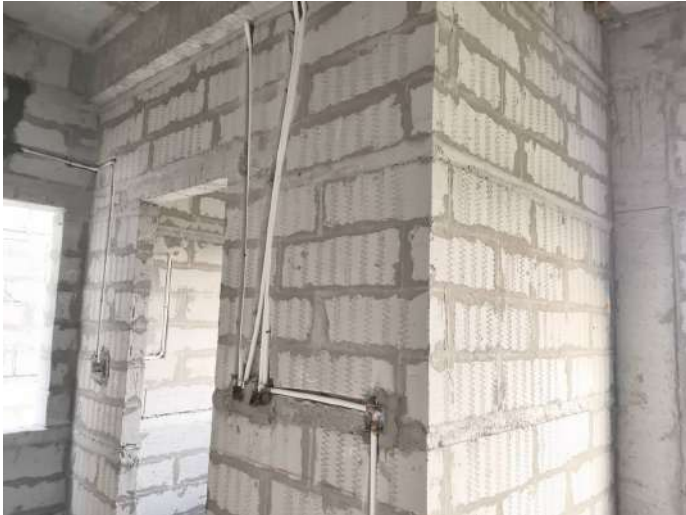
V23 - Instllation of Wall chasing & Electrical conduits
