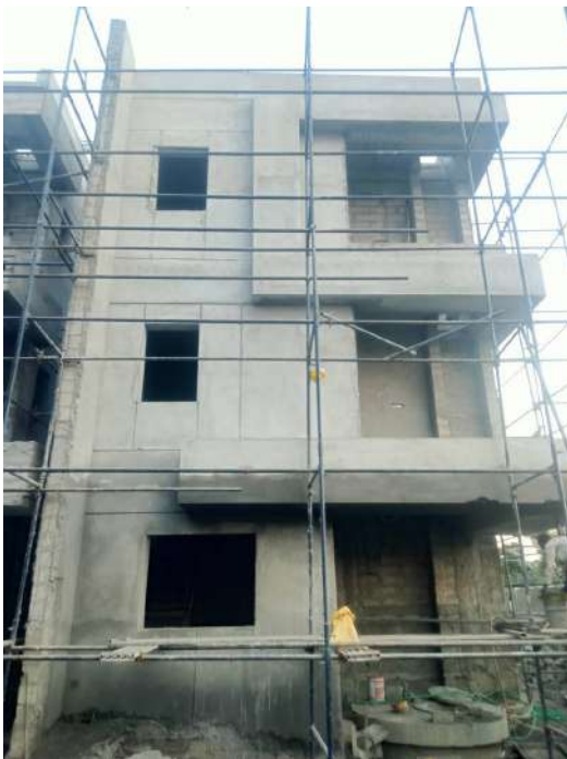
V38 - External Plastering
