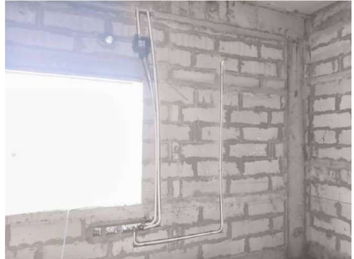
V23 - Instllation of Wall chasing & Electrical conduits
