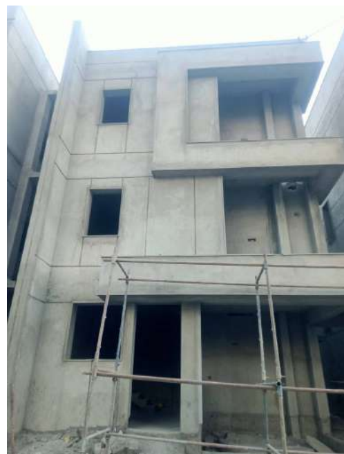
V44 - External Plastering
