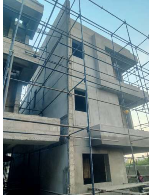
V38 - External Plastering
