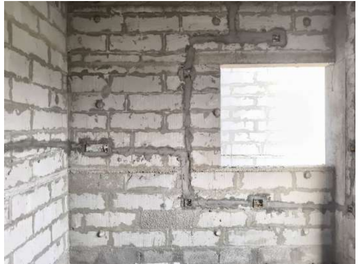
V24 - Instllation of Wall chasing & Electrical conduits
