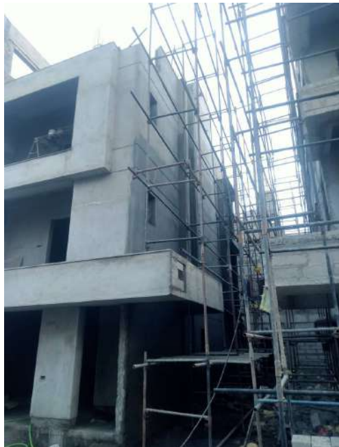
V41 - External Plastering
