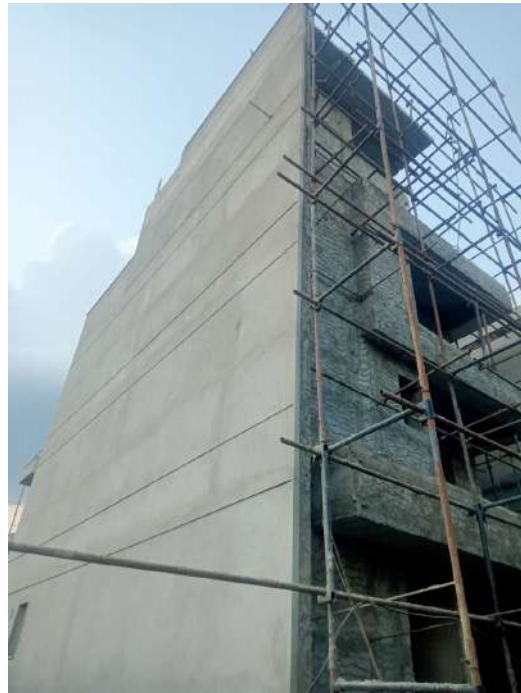
V39 - External Plastering
