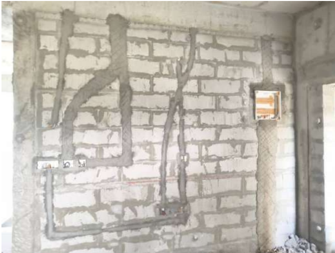
V24 - Instllation of Wall chasing & Electrical conduits
