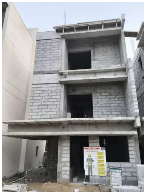
V22 - Instllation of Wall chasing & Electrical conduits
