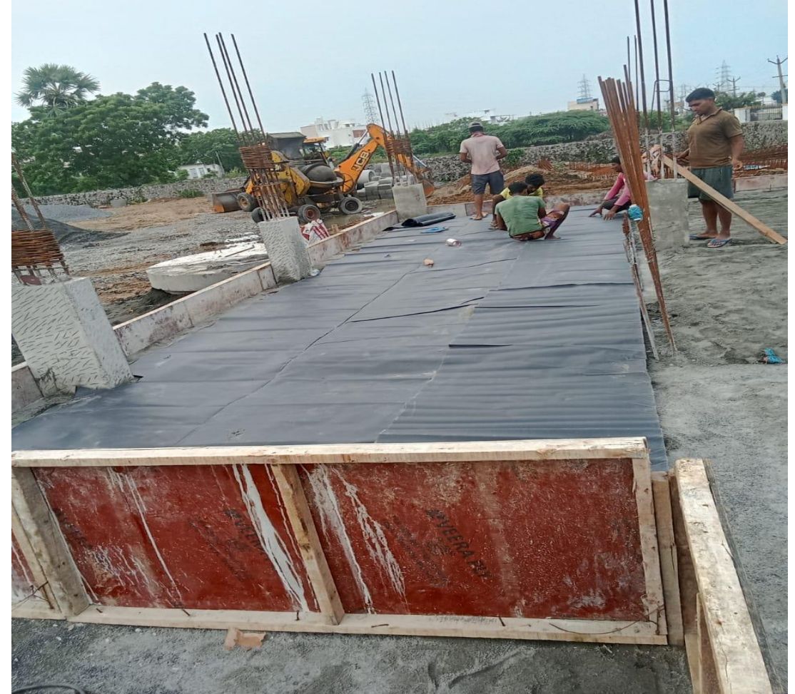
Villa No.20 Basement ATT & HDPE Sheet Laying
