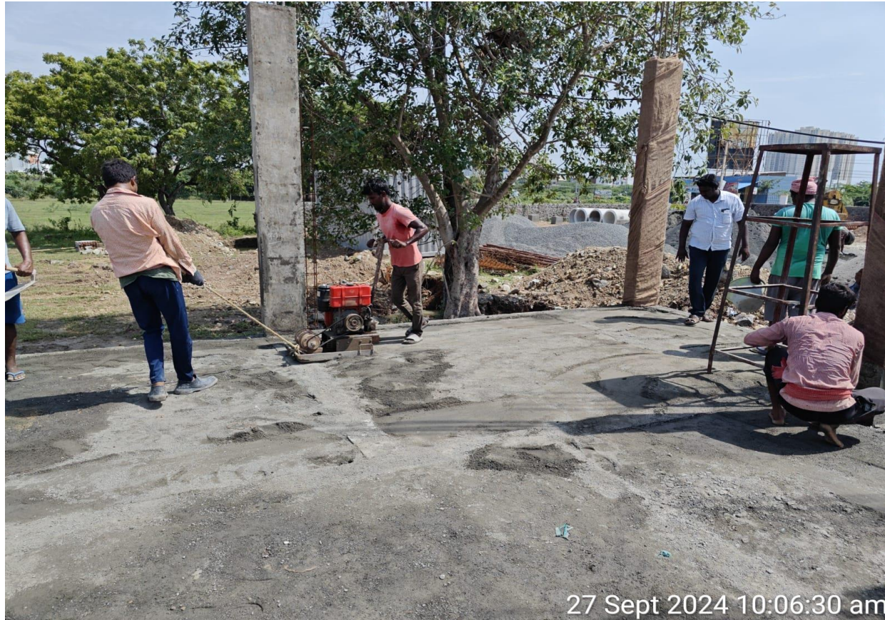
Villa No.16 Basement Filling Compaction & ATT
