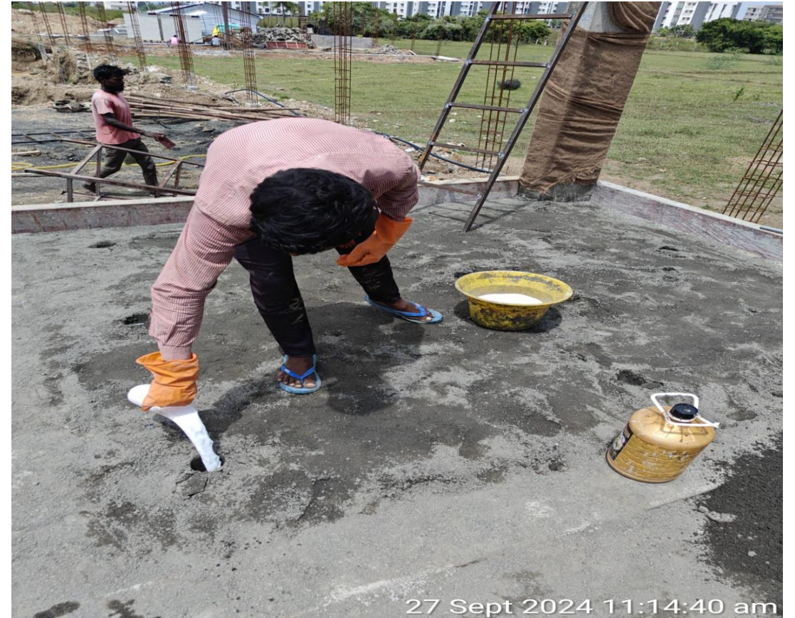
Villa No.16 Basement Filling Compaction & ATT
