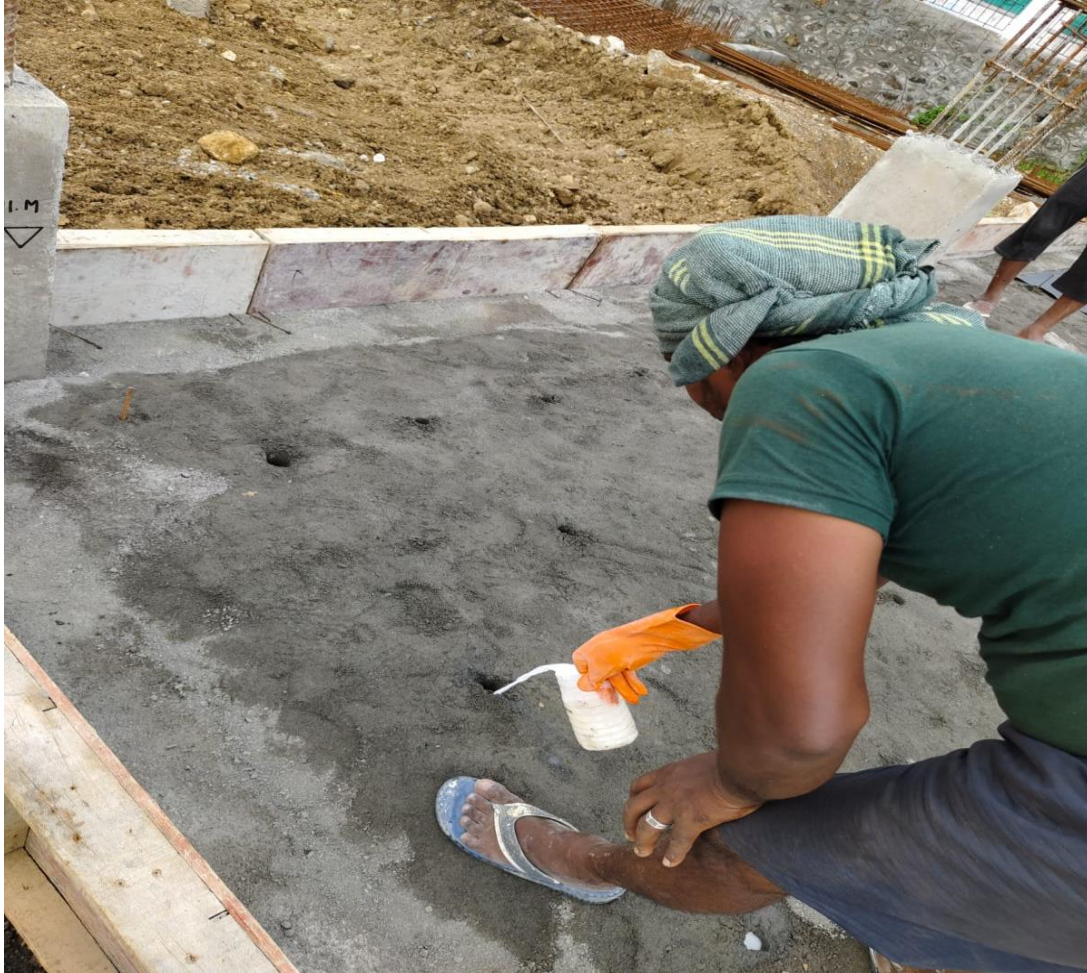
Villa No.20 Basement ATT & HDPE Sheet Laying
