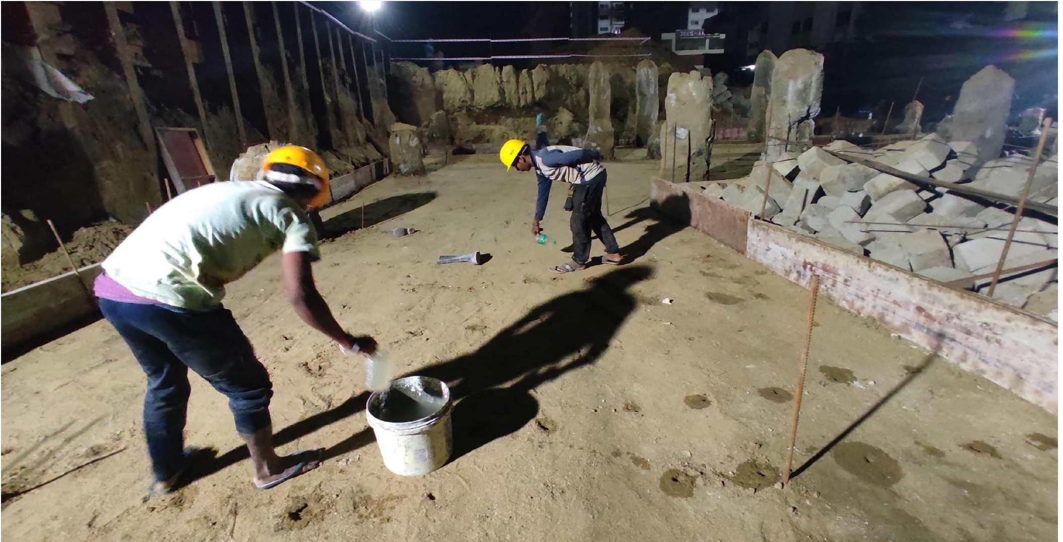
Pour 02 area Anti Termite works completed.
