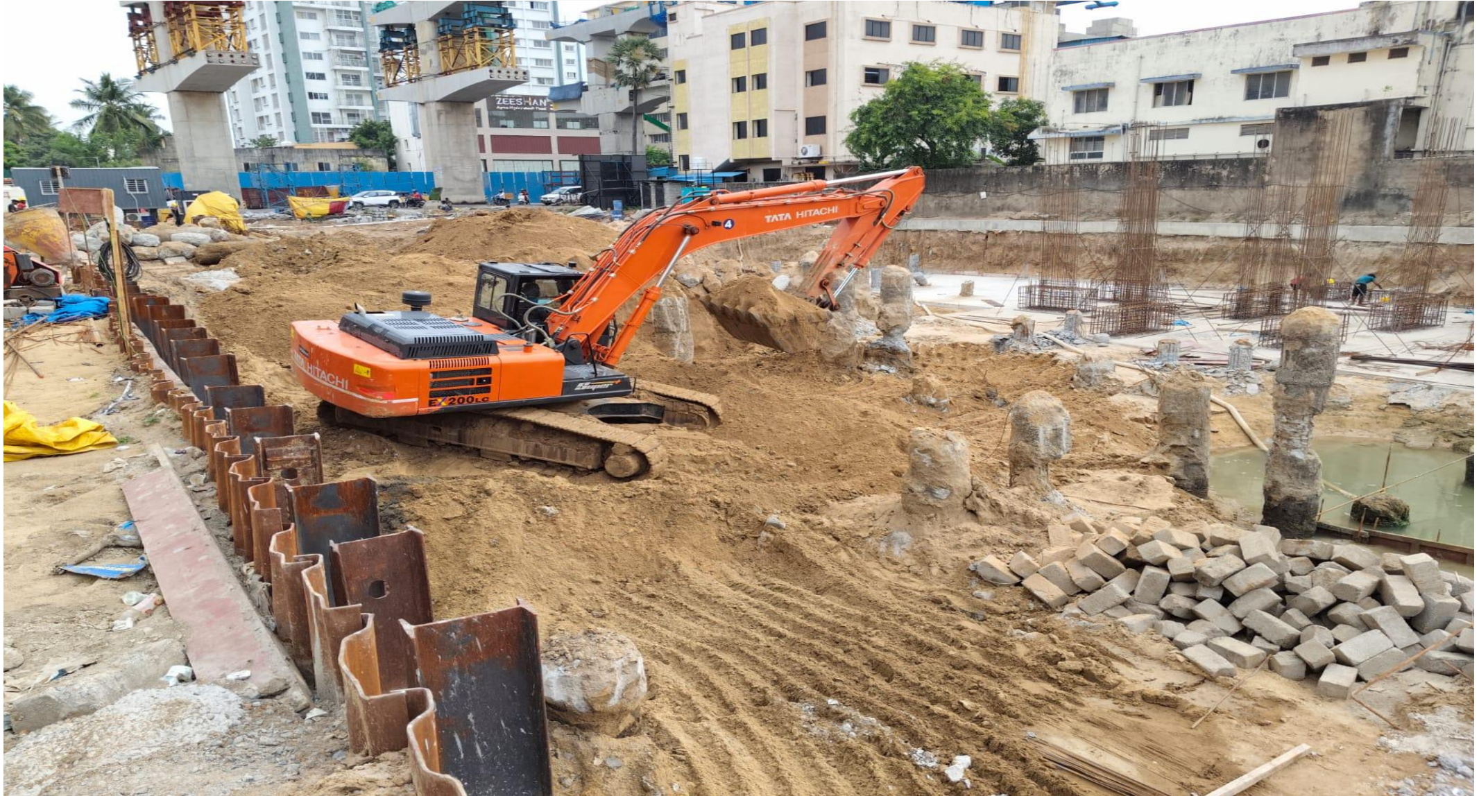
Pour - 02 area excavation works.
