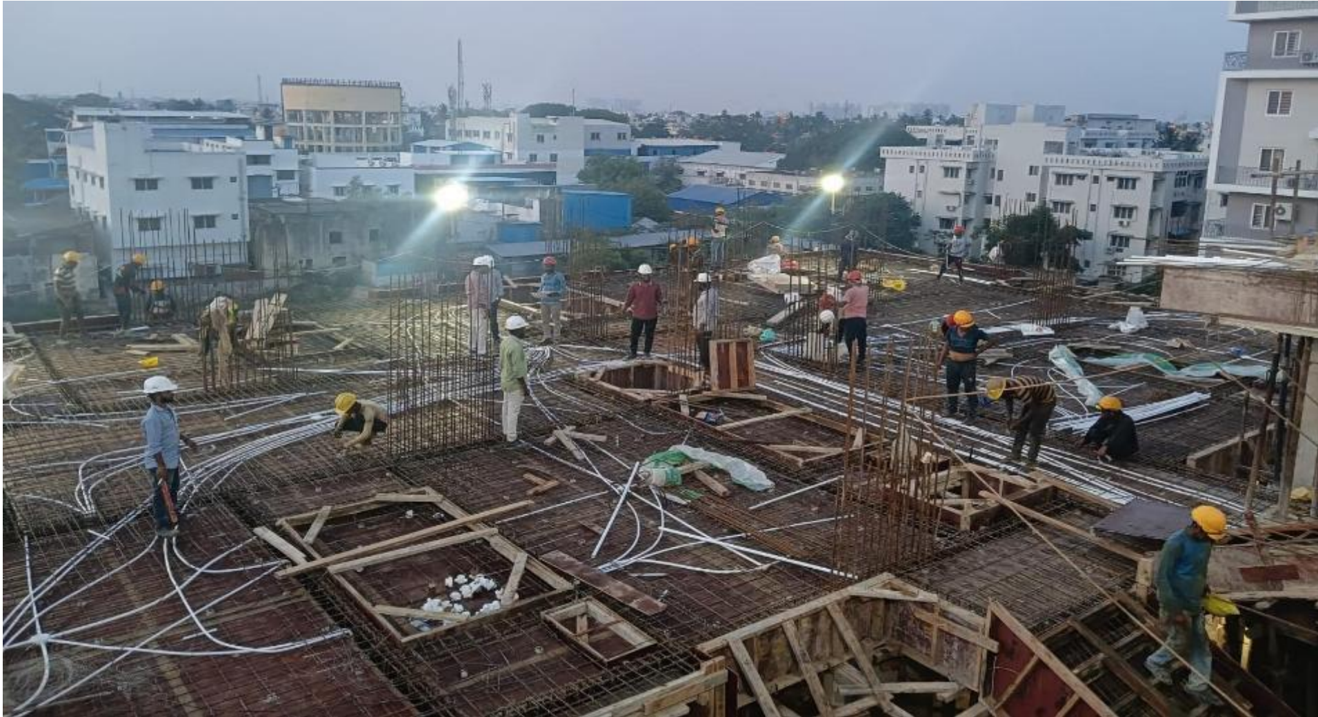
Pour 2 – 3 rd floor roof electrical conduit laying work completed.
