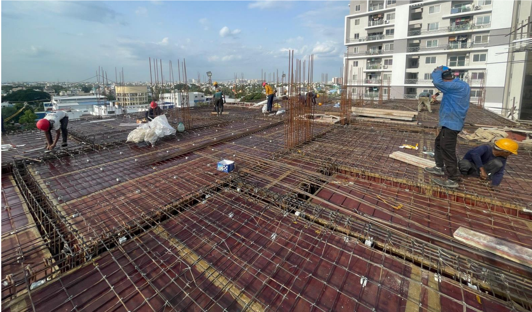
Pour 2, 6 th Roof – reinforcement work
