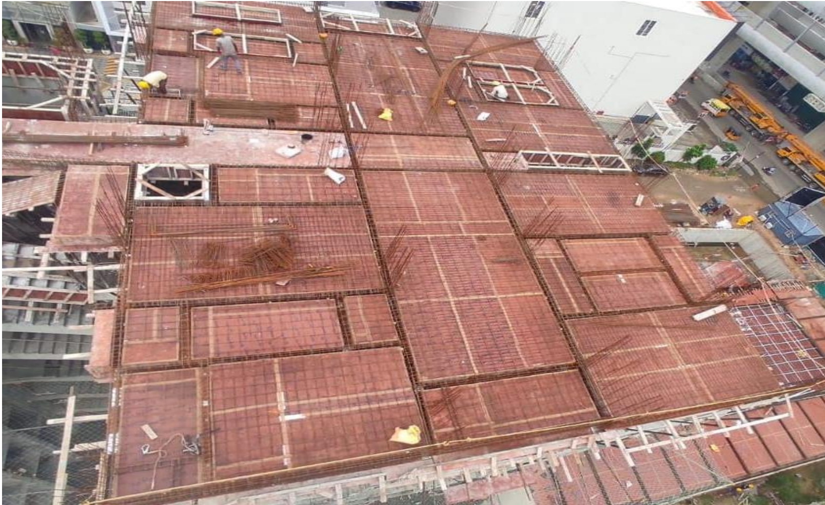
Pour 1, 7 th Roof – Reinforcement work
