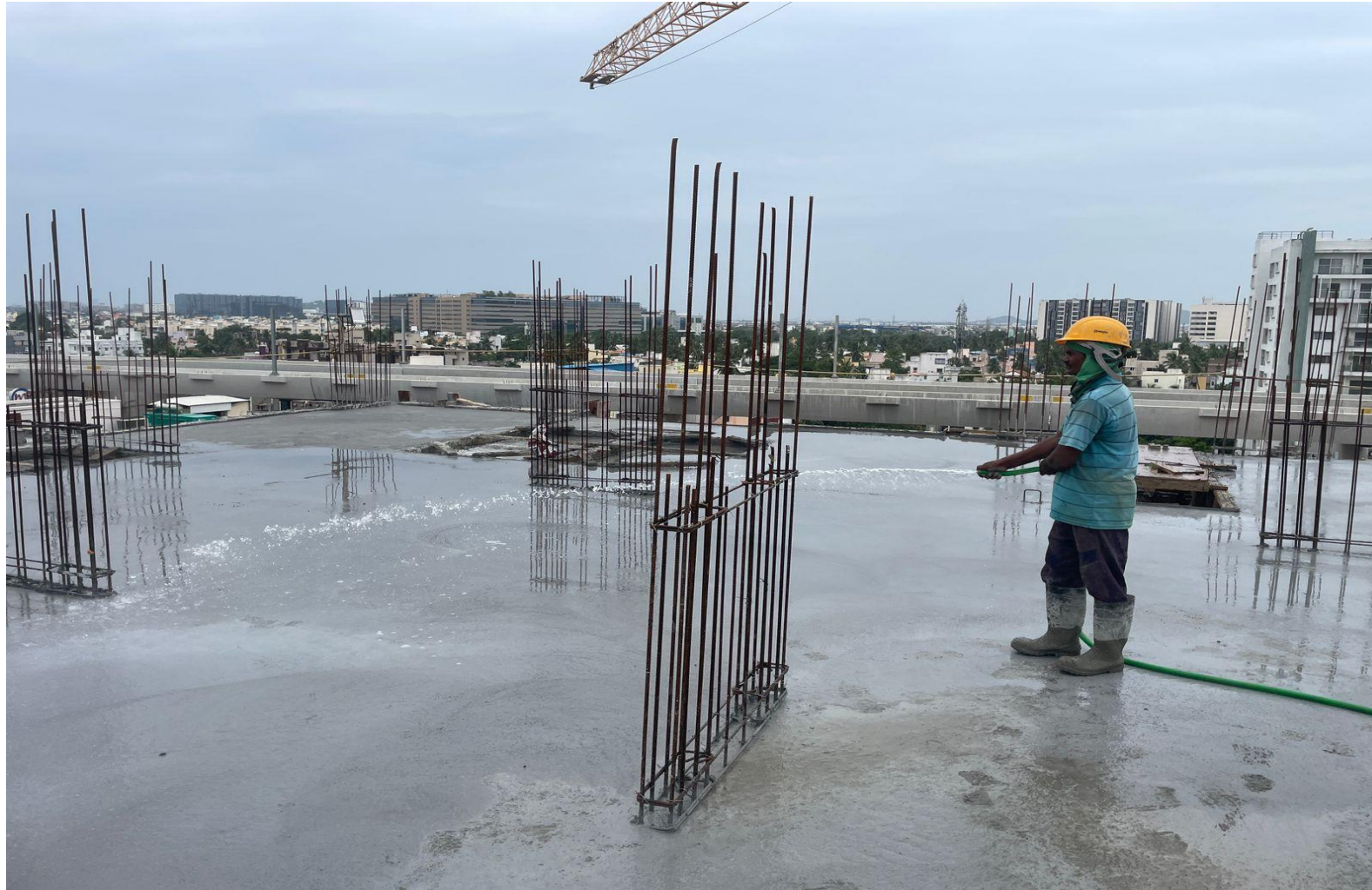
Pour 1, 7 th Roof – Curing work
