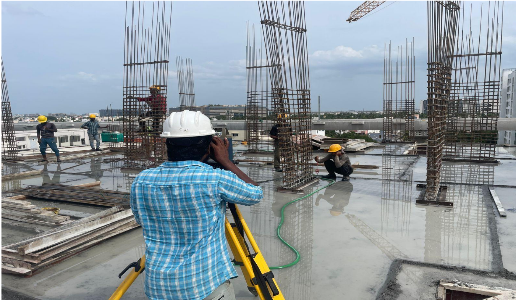
Pour 1 – 7 th floor column marking work.
