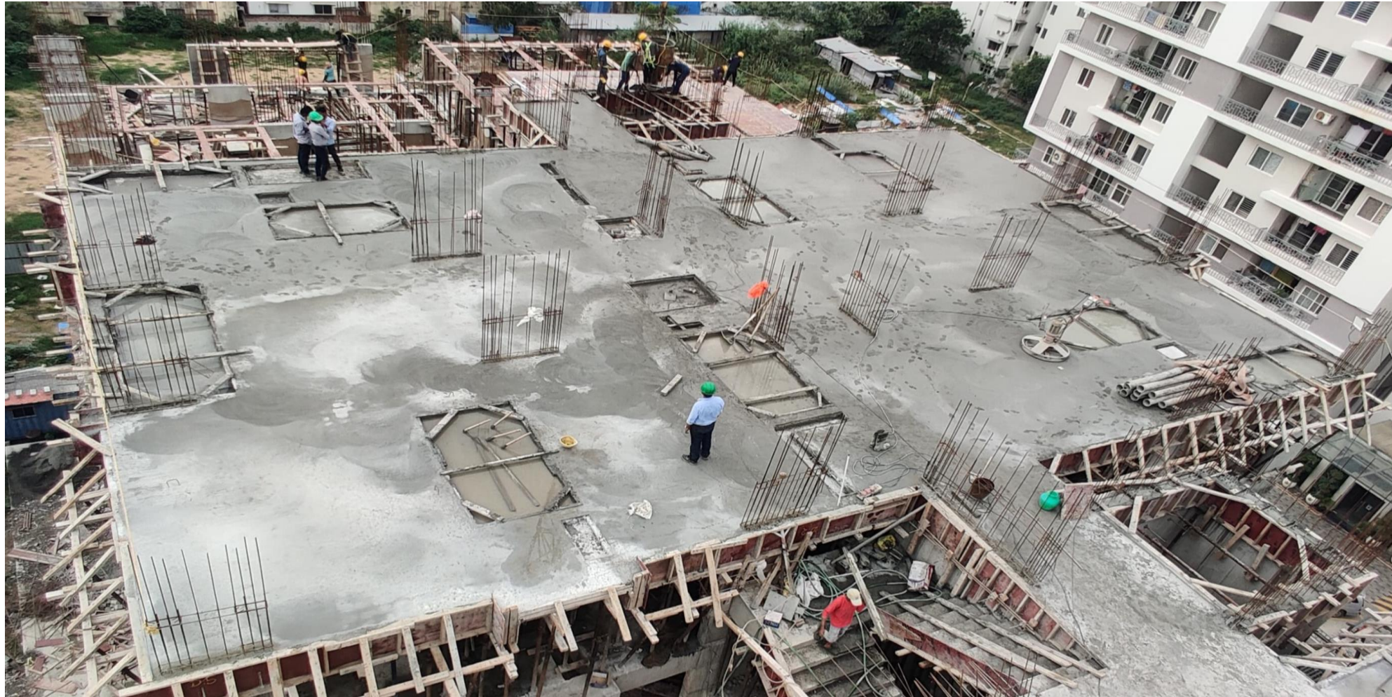
Pour 1, 7 th Roof – Concrete work
