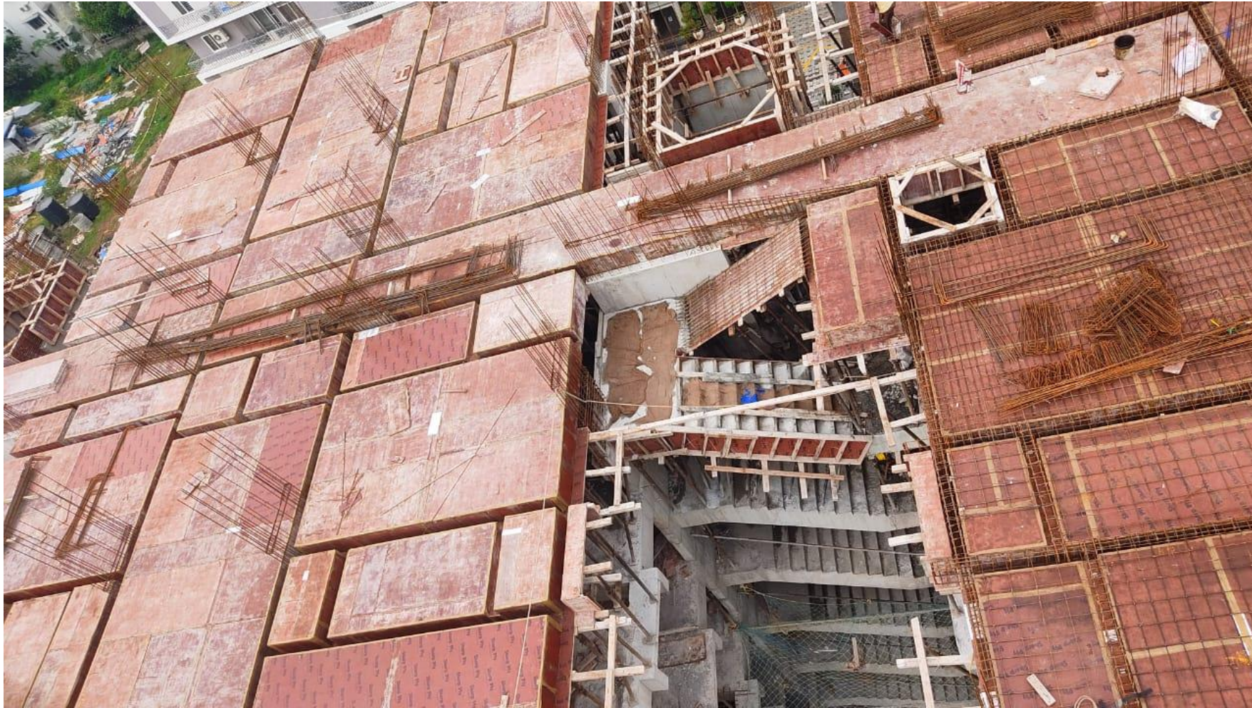
Pour 1, 7 th Roof – Shuttering work
