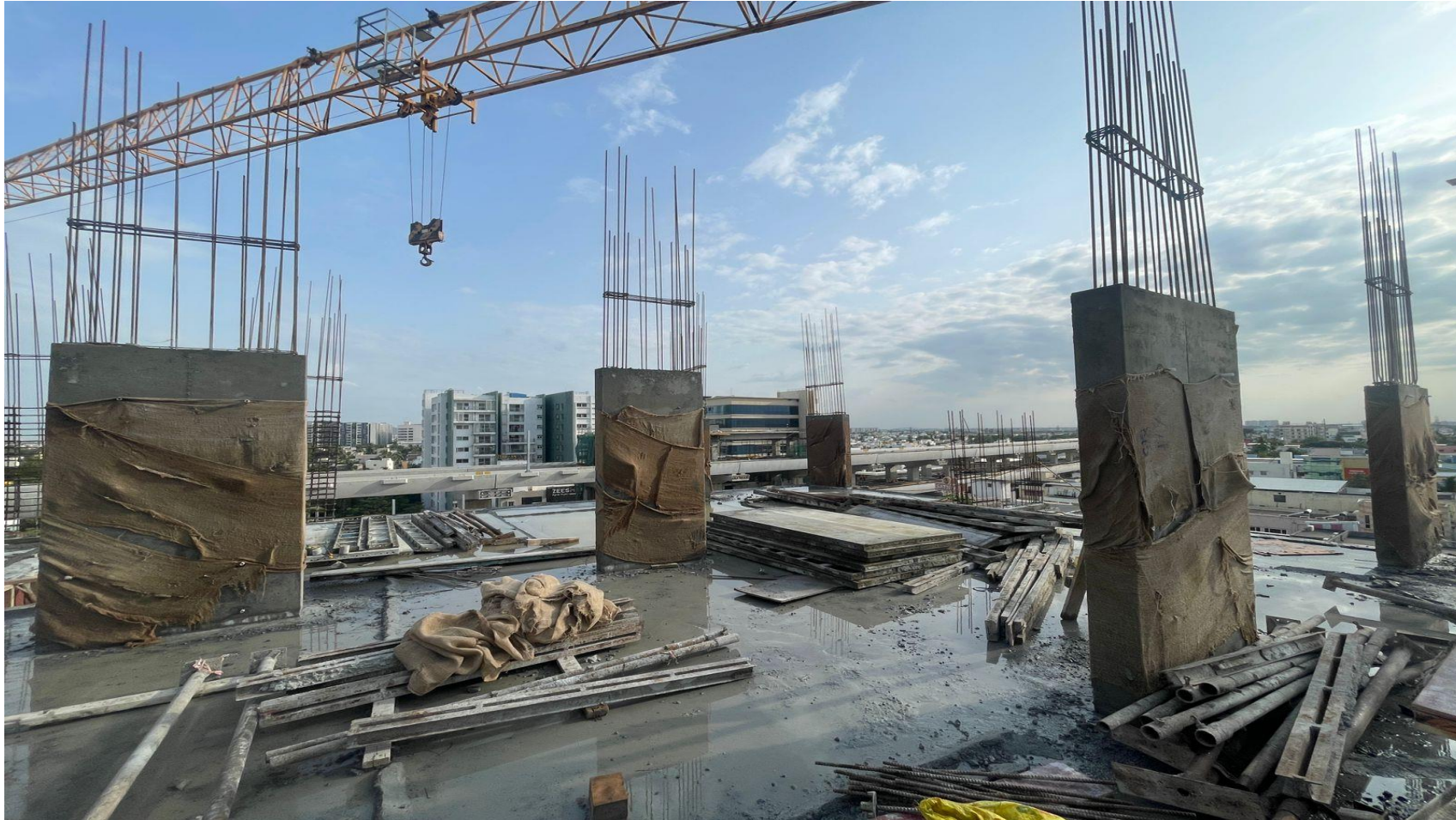
Pour 1, 8 th Floor – Column concrete
