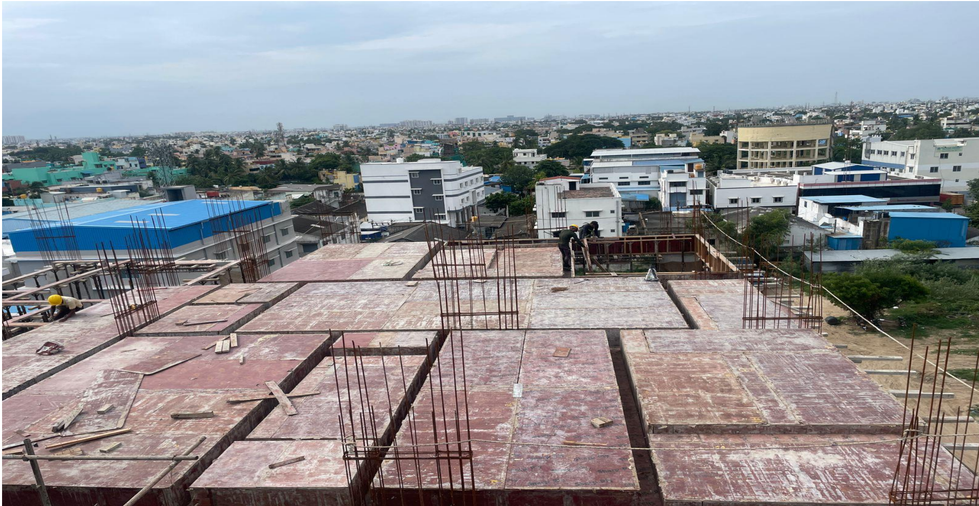
Pour 2, 6 th Roof – Shuttering work
