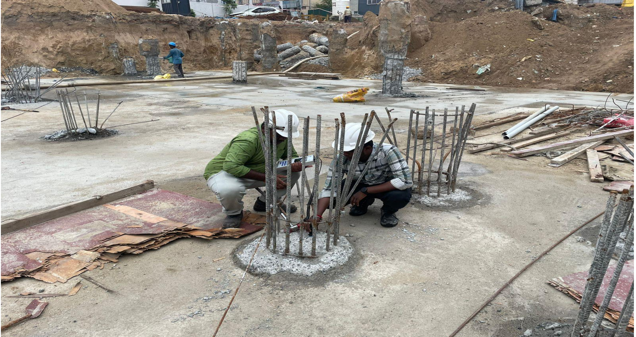
Pour 2 Area pile integrity test completed.
