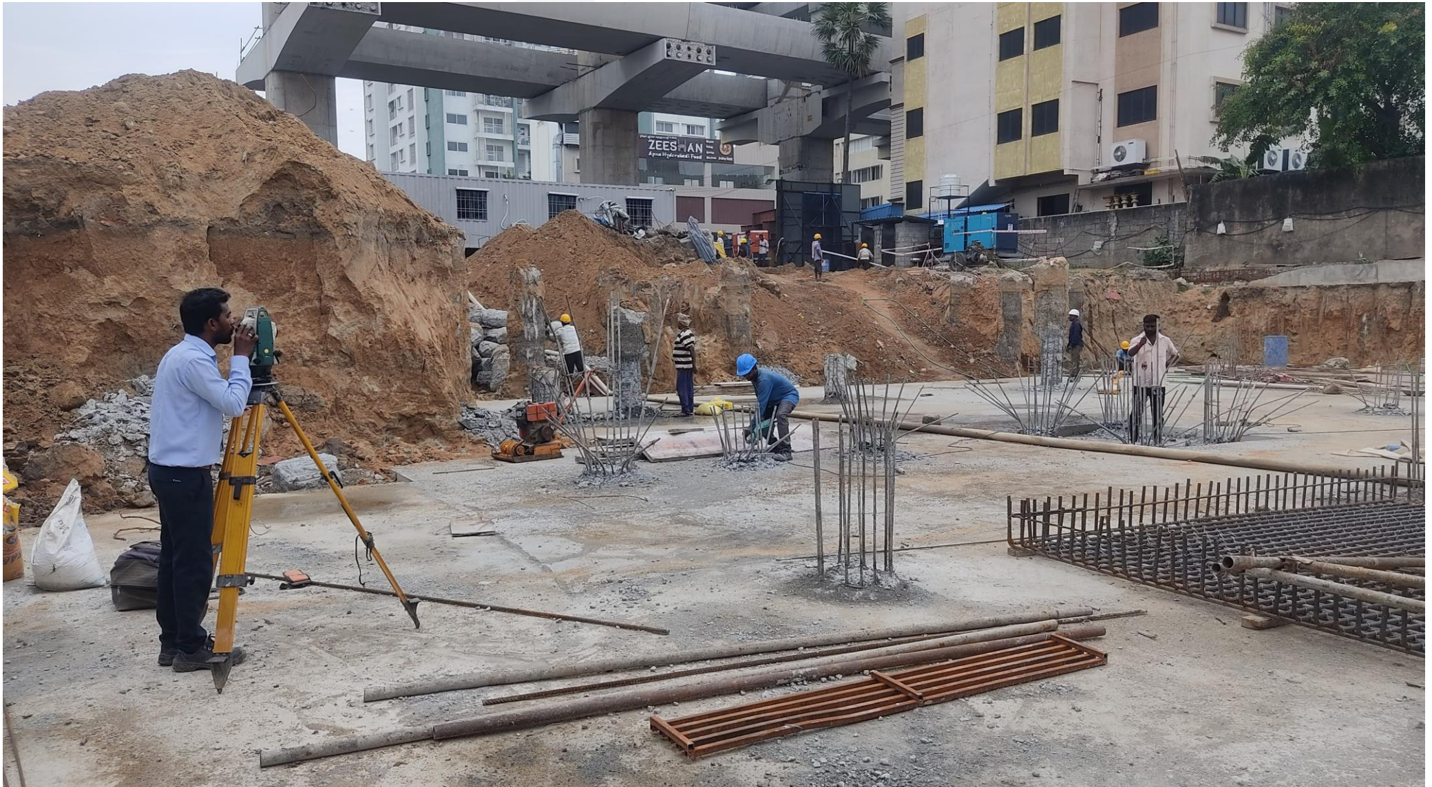
Pour 2 Area Pile eccentricity test completed.
