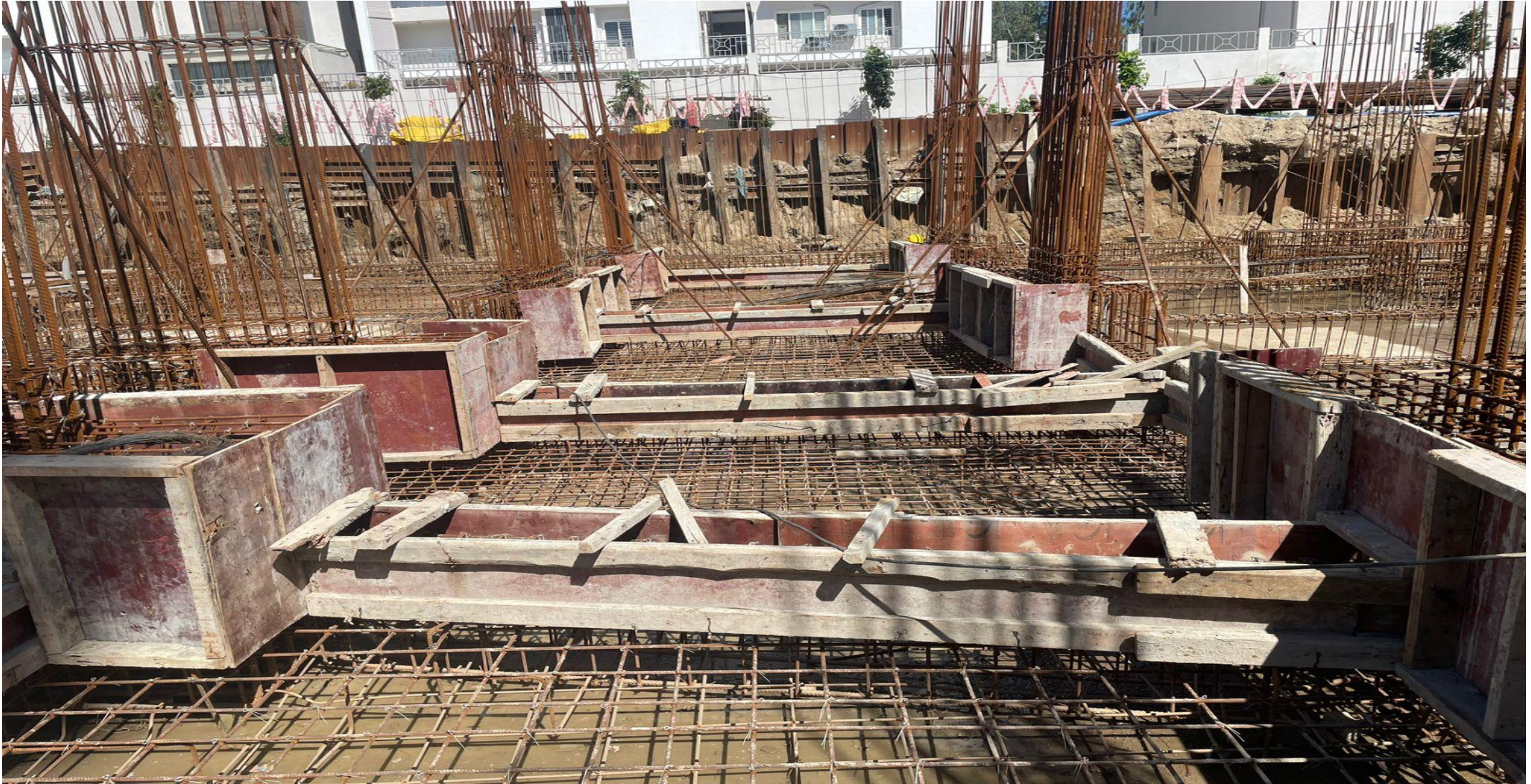
Pour 2 balance area raft pile cap & beam shuttering work in progress
