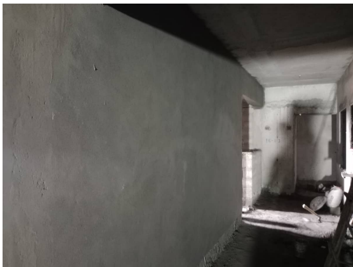
6F - Corridor Internal Plastering
