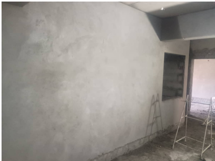
6F - Corridor Internal Plastering
