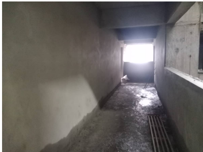
6F - Corridor Internal Plastering
