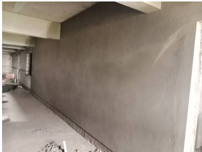
6F - Corridor Internal Plastering
