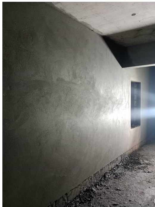
6F - Corridor Internal Plastering
