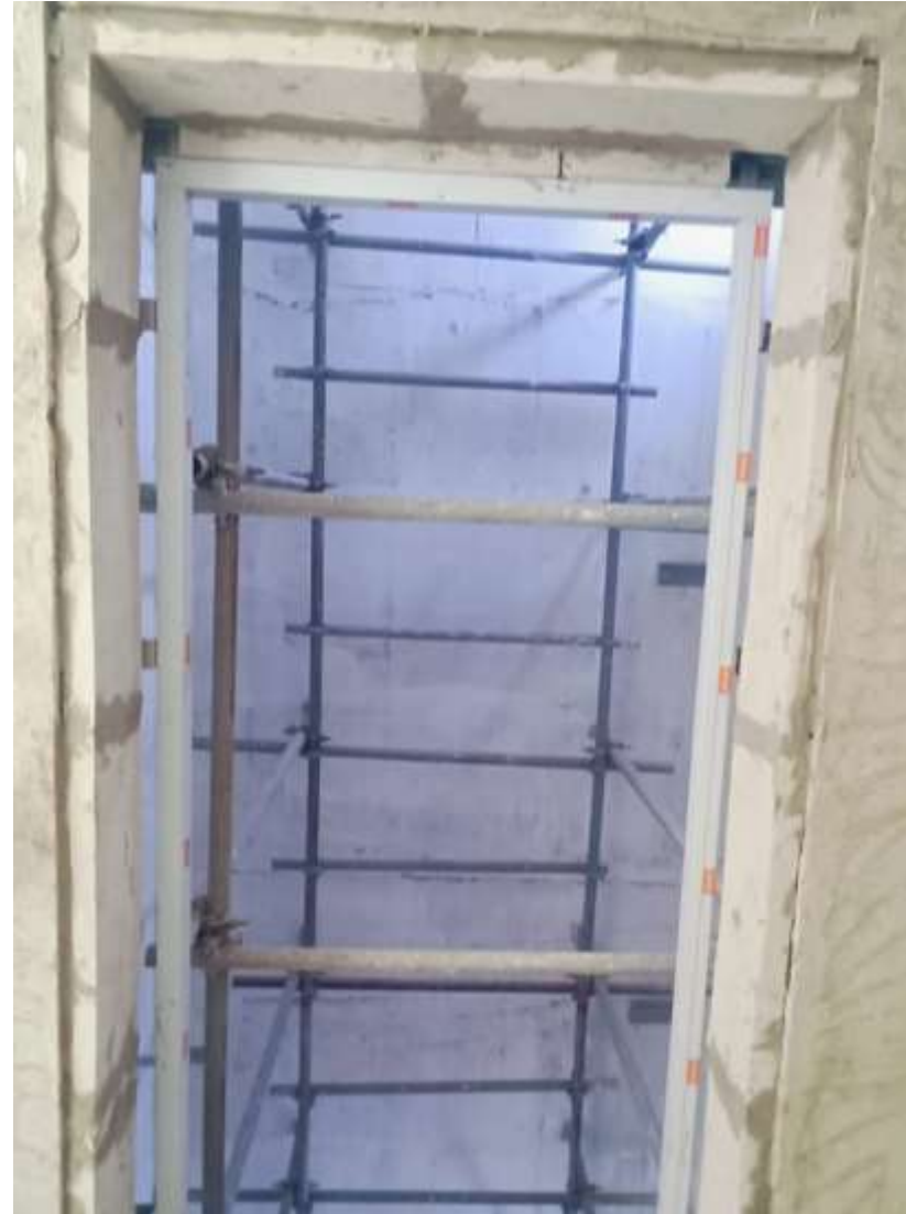
BLOCK 2 POUR 2 – LIFT JAMBS BLOCKWORK IN PROGRESS
