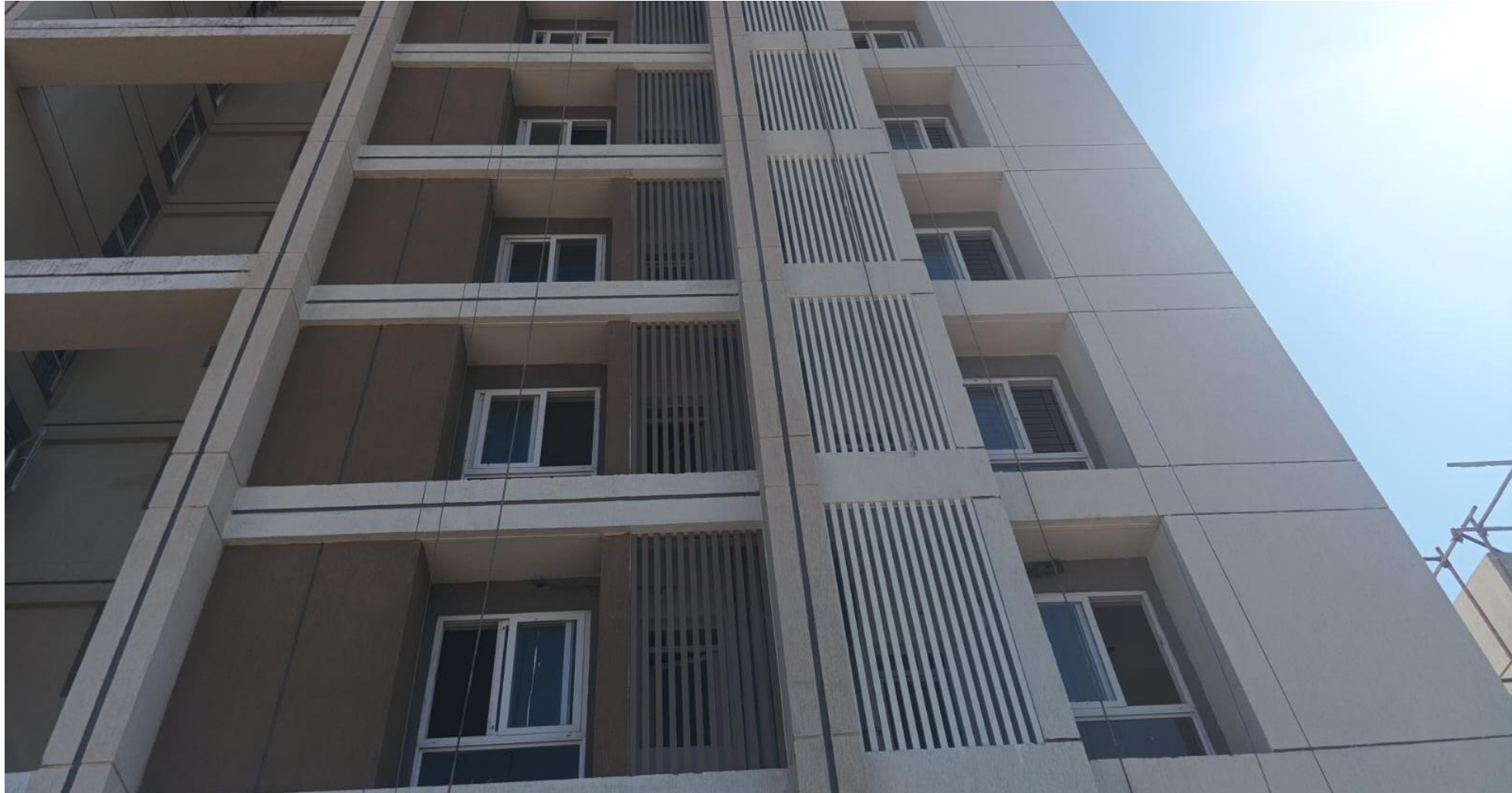
BLOCK 2 POUR 1 – EXTERNAL LOUVER FIXING WORK IN PROGRESS
